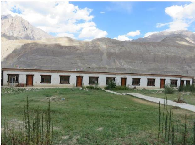
La nonnerie de Pishu, où vit une quinzaine de nonnes. Le bâtiment des cellules, en pisé, est fragilisé par la pluie et demande d'être couvert par un toit spécial.
